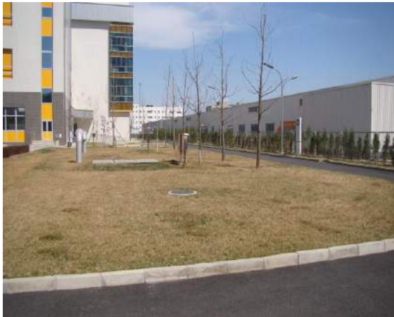
项目区雨水调蓄池
